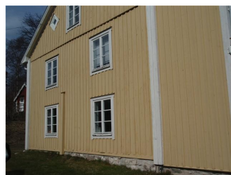
Parstugans brädfodrade knutar syns i det som senare blev "Pensionat Tornvillan"
