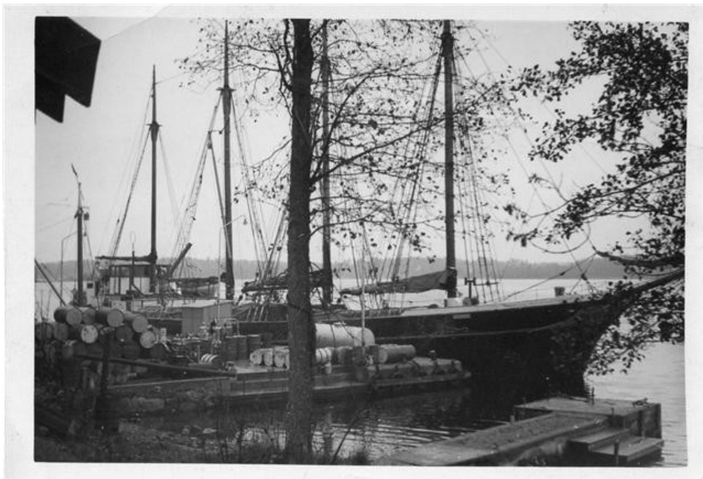
Oljekajen vid bunkerstationen
